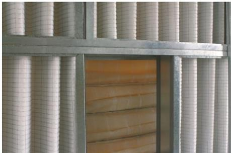
Pré-filtres et filtres plats gravimétriques de moyenne efficacité type G4 ou F5. Ils sont montés sur glissières avec joint de mousse entre le cadre des cellules et le tunnel intérieur de la centrale. La compression de ce joint assure l'étanchéité du plan filtrant. Classe F9 selon la norme NF EN 1886.
